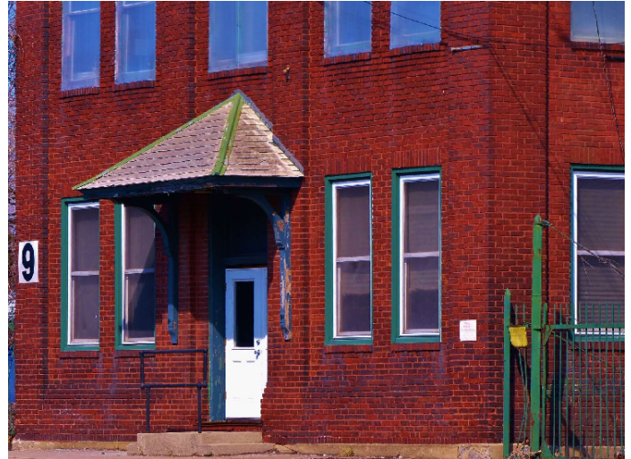
Alte Bauten kommen sehr gut ohne moderne Dämmplatten aus. Sie haben dicke Mauern, die Wärme speichern. [1]
