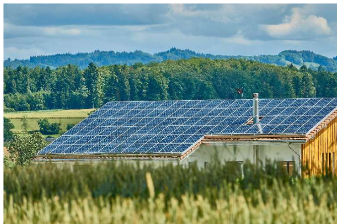
Wie lange bleiben die Komponenten einer Solarstromanlage nutzbar? [1]
