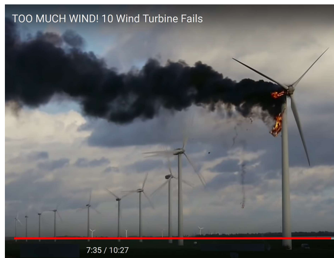
Zerstörung durch zu viel Wind ist augenfällig - Kosten bleiben verborgen [1]
