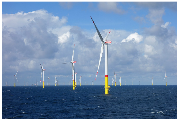
Blick von der Povel Anker auf den noch im Bau befindlichen Windpark [1]
